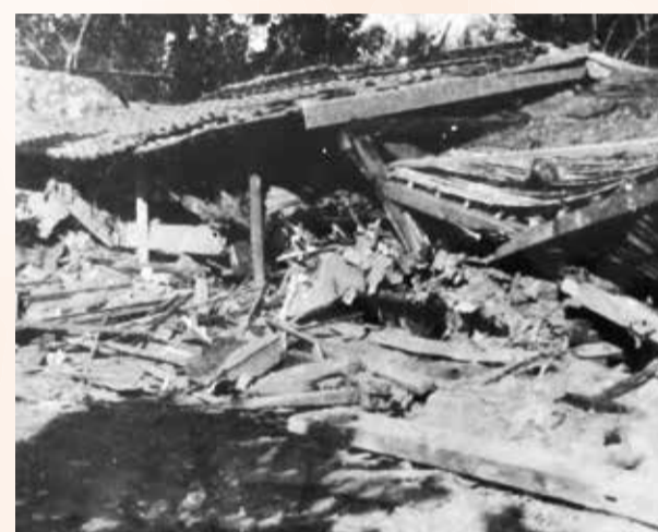
西尾市丁度町の民家倒壊
