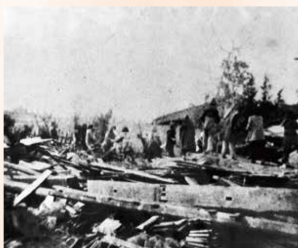
西尾市吉田小学校の倒壊
