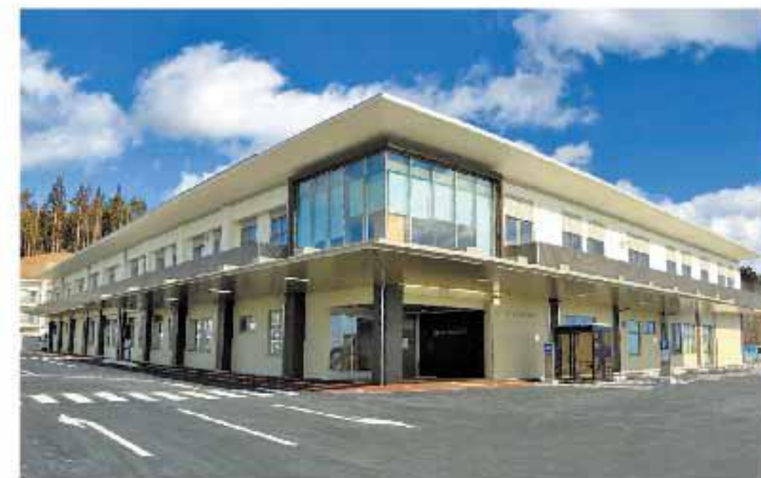
高台に再建された岩手県立高田病院
