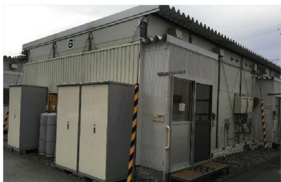
応急仮設住宅
