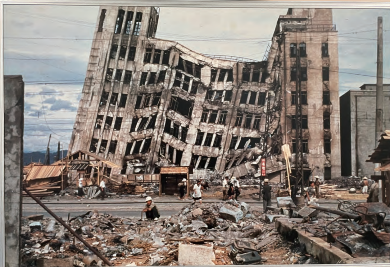
1948年福井地震 無残に折れ曲がった大和百貨店ビル 港防災センター所蔵
